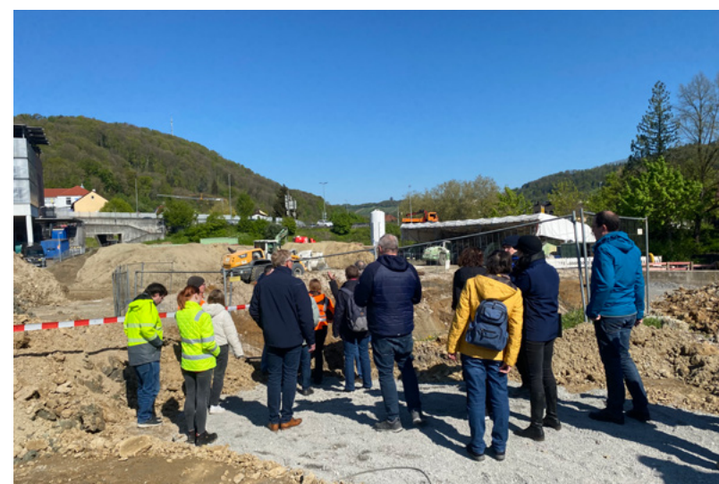
Tiefe Einblicke am Stadteingang beim Baustellengespräch im April.
