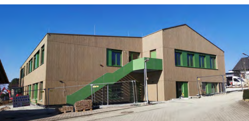
Das Kinderhaus Silberstraße in Gaisbach ist für sechs Gruppen mit einer Mensa, einem Beratungsraum und zwei Bewegungsräumen auch als Familienzentrum für die Nutzung der Dorfgemeinschaft ausgelegt.
